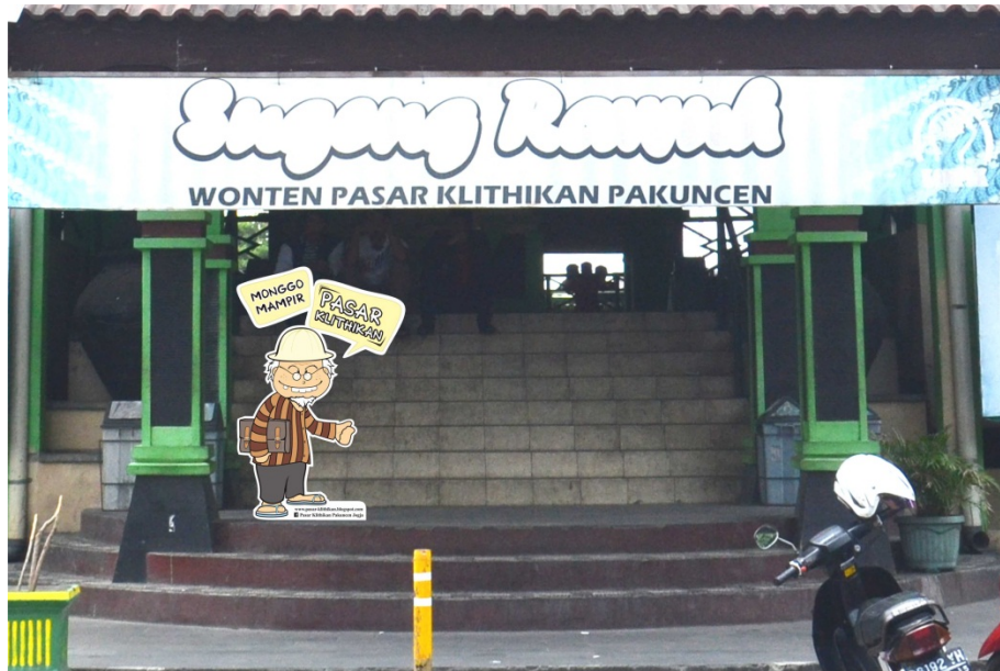
Penempatan standing character pada bagian pintu masuk
