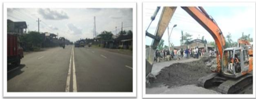
Foto 1. Gambar kondisi jalan raya Yogyakarta-Magelang sebelum (kiri) dan pasca terjadinya banjir lahar dingin di sekitar Dusun Gempol (kanan)
