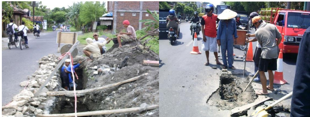
Gambar 8. Perbaikan Jaringan Air Limbah Domestik Sumber : Balai IPAL Sewon, 2014
