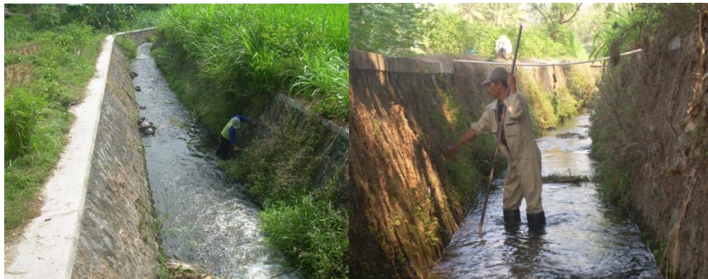
Gambar 9. Pemeliharaan atau Pembersihan Saluran Buang ( Outlet ) Sumber : Balai IPAL Sewon, 2014
