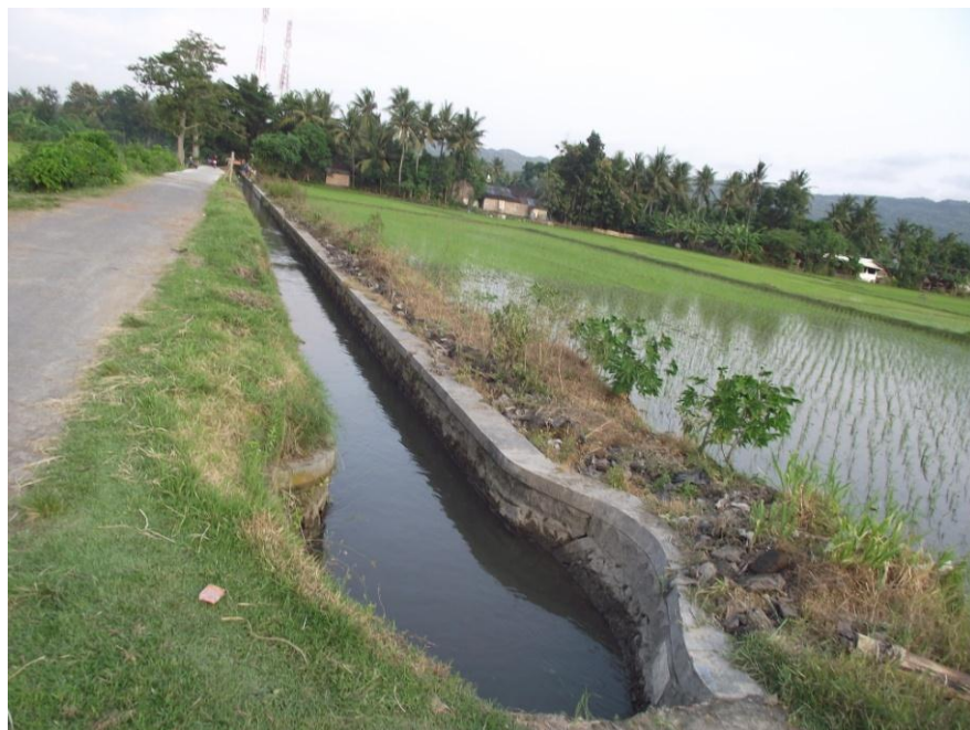
Gambar 8. Saluran jaringan irigasi Bendung Tegal
