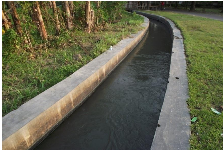
Gambar 9. Saluran jaringan irigasi Bendung Tegal
