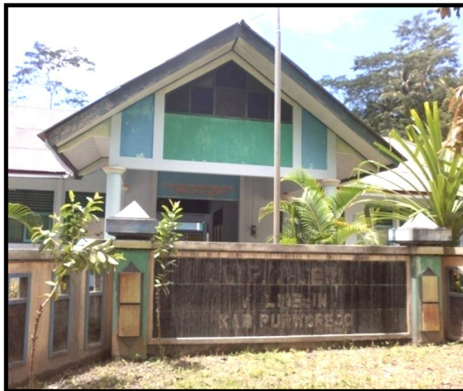
Gambar II: Gedung sekolah, tampak depan (Dokumentasi: Pawit Resmiyati, Kamis, 6 Februari 2014)
