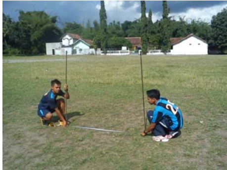
Gb. 11. Pemasangan pancang
