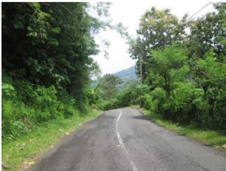
Gambar. Jalan rusak
