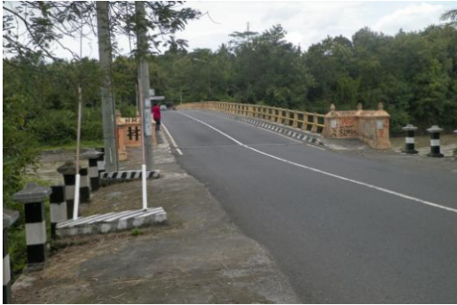
Gambar. Jembatan Penghubung kec. Nanggulan dengan Kab. Sleman
