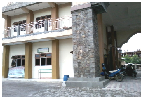
Asrama putera dan ruang kelas yang sedang dalam pembangunan
