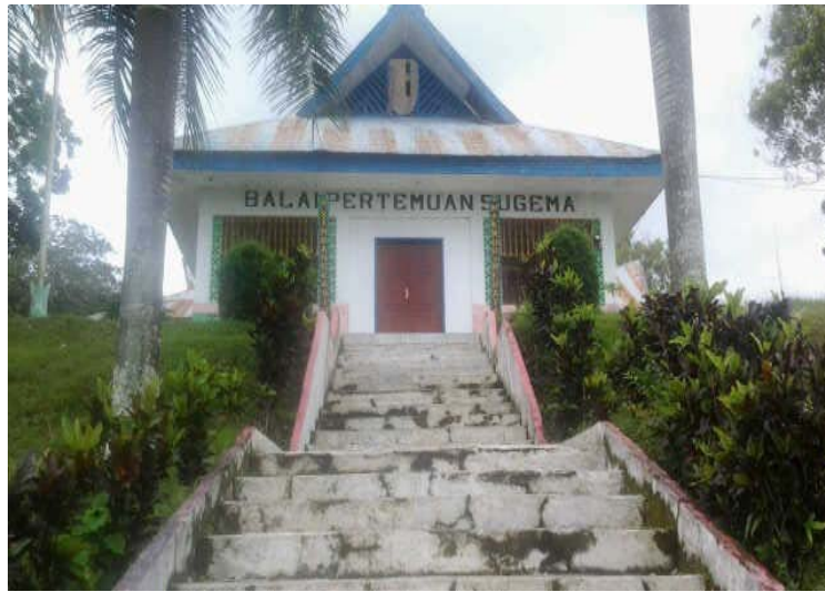
Gambar 3. Kondisi bangunan bali pertemuan Sugema atau Kantor kepala desa
