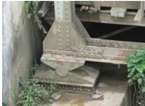
Gambar 7. Penggunaan tumpuan sendi pada struktur jembatan (sumber: Faqih, 2012)
