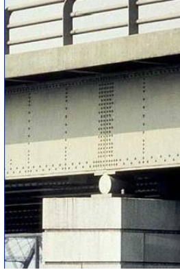
Gambar 9. Penggunaan tumpuan rol pada struktur atas jembatan (sumber: Faqih, 2012)
