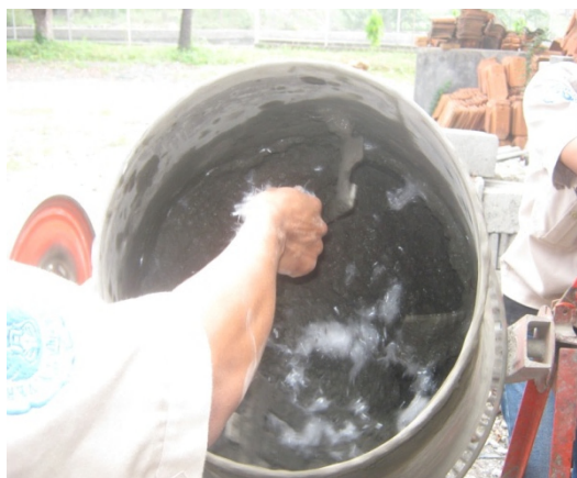
Foto 9. Proses Pengadukan beton.
