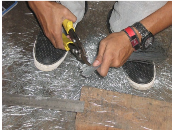
Foto 1. Pemotongan Serat kawat ( steel fiber/SF )
