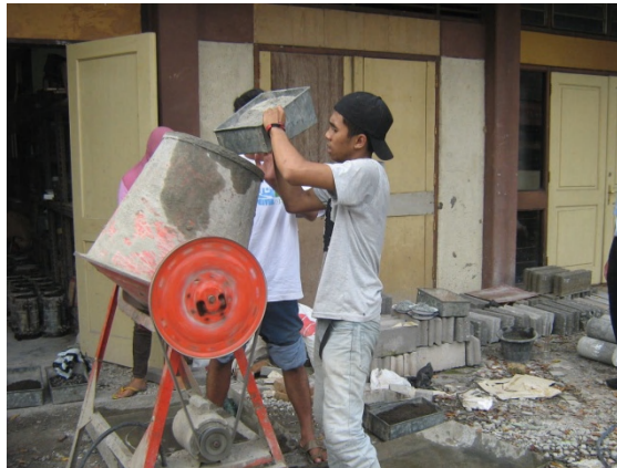
Foto 8. Proses pencampuran beton ( steel fiber/SF ) dan serat polypropylene (PP) .
