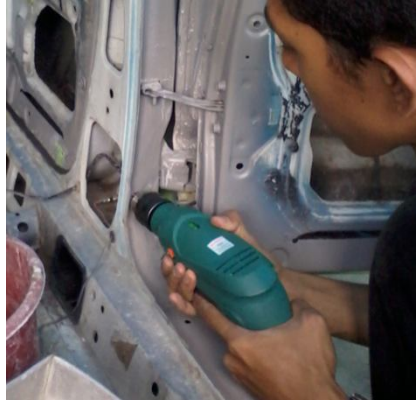
Gambar 9. Pengeboran lubang untuk jalur kabel.
